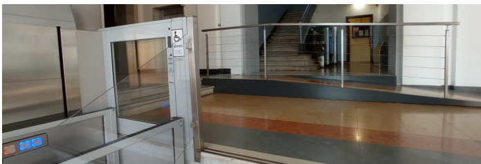
Abbattimento barriere architettoniche Palazzo Comunale
