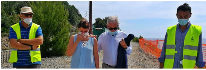
Sopralluogo cantiere Pista Ciclabile
