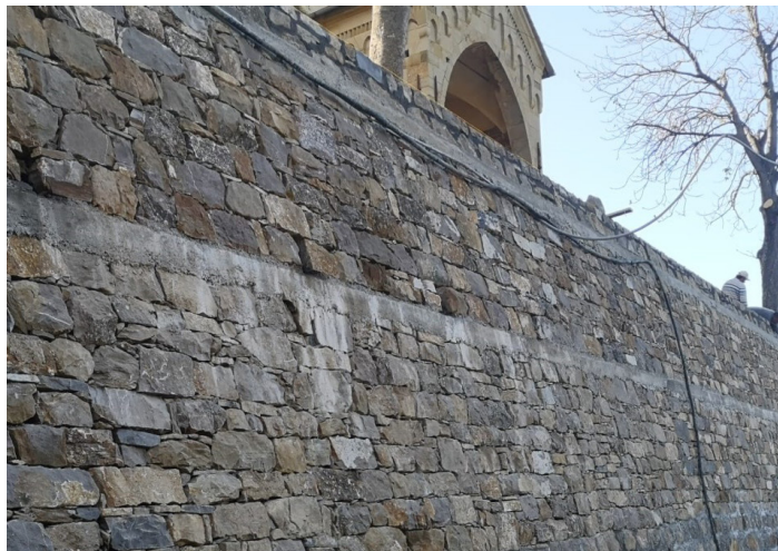
Dall'alto: Quota assegnata alla Città di Imperia nel Piano di riparto dei fondi di protezione civile, 2019-2020 (schema) Interventi al Molo Lungo di Oneglia Interventi in Via Boine Messa in sicurezza del muro di sostegno del sagrato di N.S. delle Grazie
