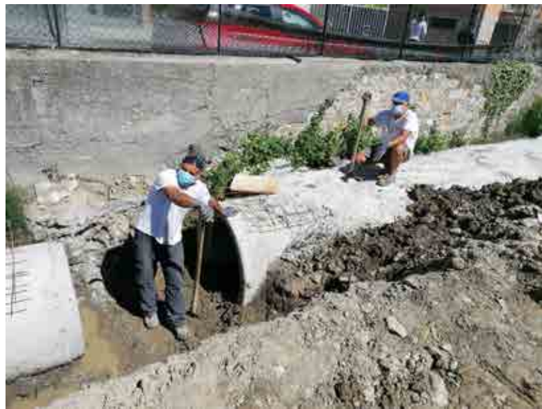
Nuova tubazione lungo via Lucas Bormani con scarico in torrente Evigno
