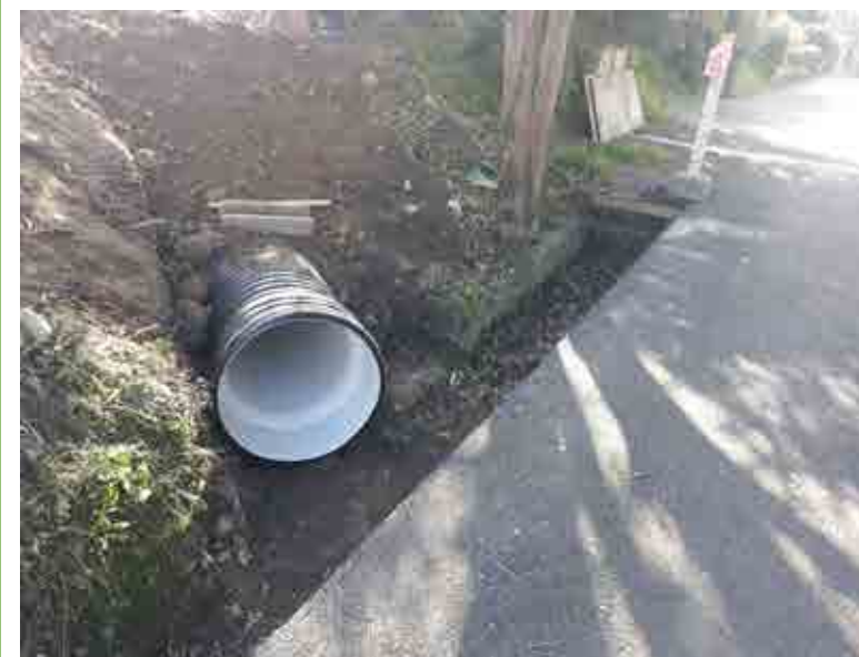
Nuova tubazione lungo ex sedime con scarico in torrente Varcavello
